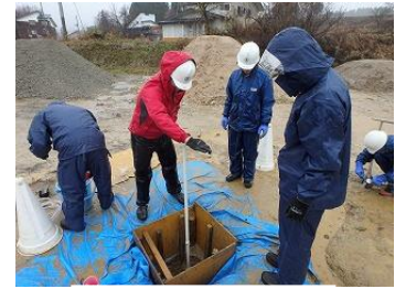
図5 先孔延長工事
