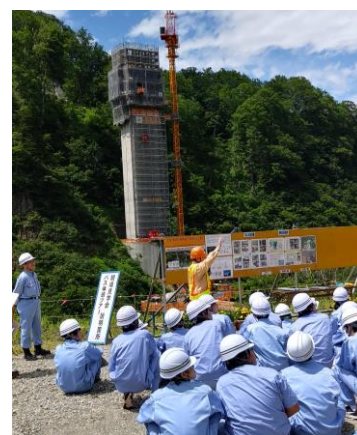
図 1 国道 289 号線工事 (三条市)
