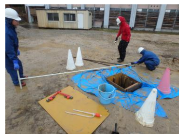
図8 掘削距離確認
