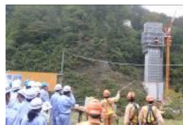
国道 289 号線工事 (三条市)
